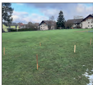
Die Pflöcke für den Pumptrack sind schon eingeschlagen. Es fehlt nur noch die Baubewilligung. Dagegen sind allerdings mehrere Einsprachen eingegangen. (Bild: hwh)
