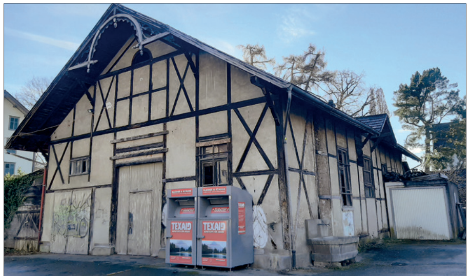
Wird abgebrochen – die alte Sek-Turnhalle an der Buchser Oberstrasse.
