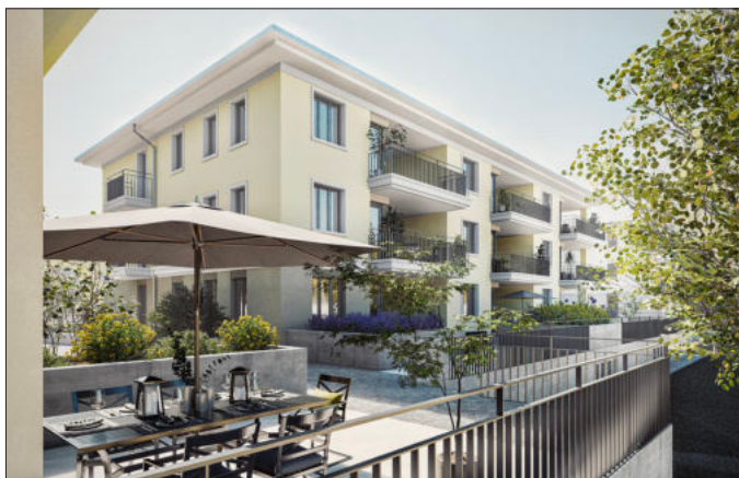
Einer der drei Baukörper – Frontansicht von Haus B.
