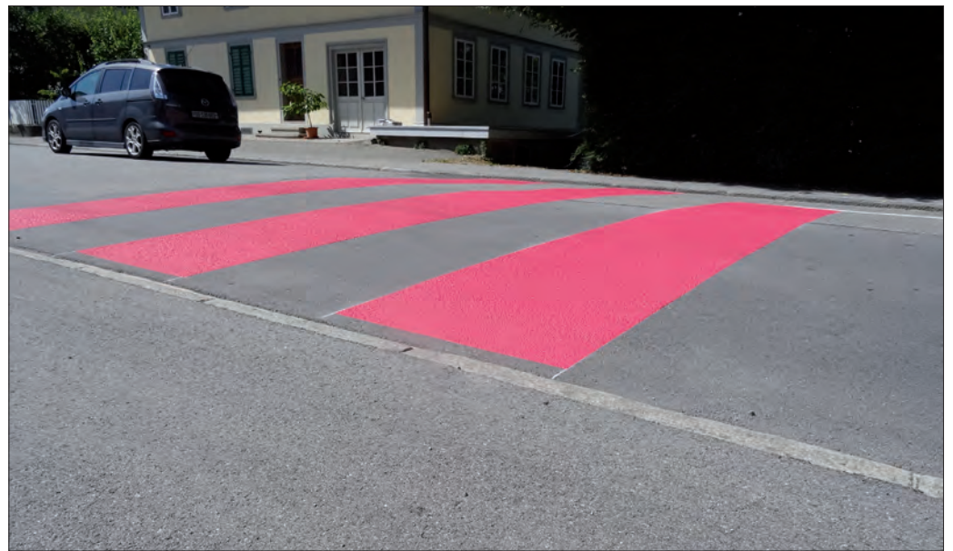
Wie hier an der Unterstrasse sind die Einfahrten in die verkehrsberuhigte Zone schon markiert.
