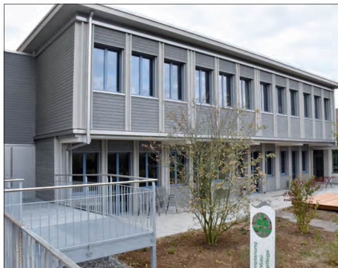
Der neu erstellte Zwischenbau. (Bild: mh)
