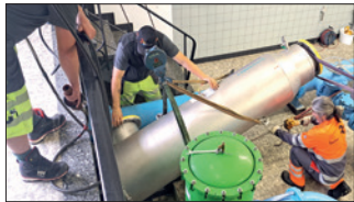
Einbau der neuen UV-Anlage im Pumpwerk Hermiswil (Bild: ewk)
