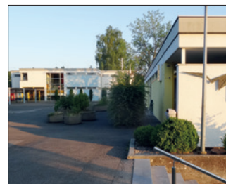
Nächste Etappe bei der Schulraumerweiterung: Die Zyklus-2-Bauten im Mittelholz sind veraltet.
