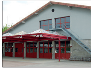
Die Zivilschutzanlage Moosrain soll umgebaut und auch künftig als militärische Truppenunterkunft genutzt werden.
