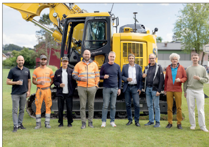
Gemeinsam stossen sie auf den Spatenstich an (von links): Simon Durrer (Durrer Gartenbau), Remo Christ (Sutter Bauunternehmung), Alessio Marcorin (Flying Metal), Marco Kunz (Sutter Bauunternehmung), Marc Guggenbühler (Verein Pump'n'jump), Roland Althaus (EWK Herzogenbuchsee), Hansueli Ingold (Gemeinderat Niederörs), Hans Wyssmann und Janosch Bigler (beide Verein Pump'n'jump). (Bild: mj)
