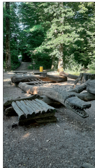
Der Sanierung des Spielplatzes im Lööliwald steht nichts mehr im Wege.
